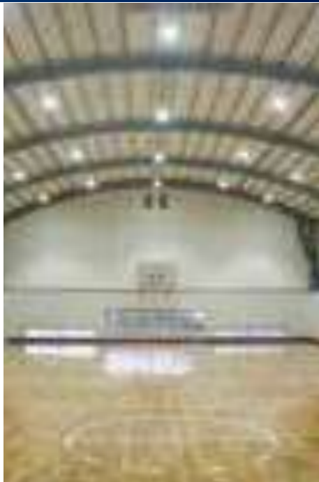
【体育館照明】竹田南高等学校
