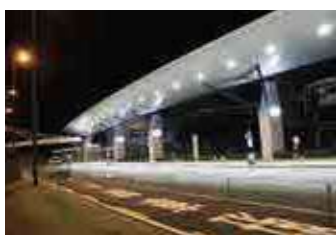
【街路照明】 高松空港
