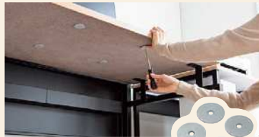
専用金具を取付け。
